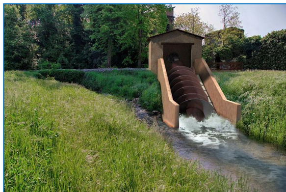
Idroelettrico (mini hydro)
